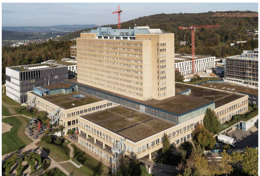
Nach mehr als 44 Jahren im Betrieb: Der Rückbau des alten Spitals steht nach der Inbetriebnahme des Neubaus an.
